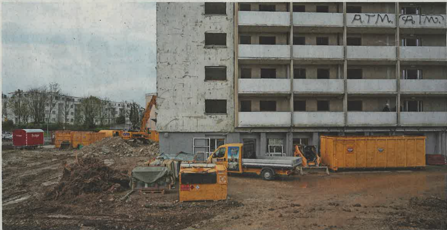
Der abbruchreife Block in Zollkofen: 150 ausgesiedelte Fenster von hier landen in der Ukraine. Foto: Raphael Moser
