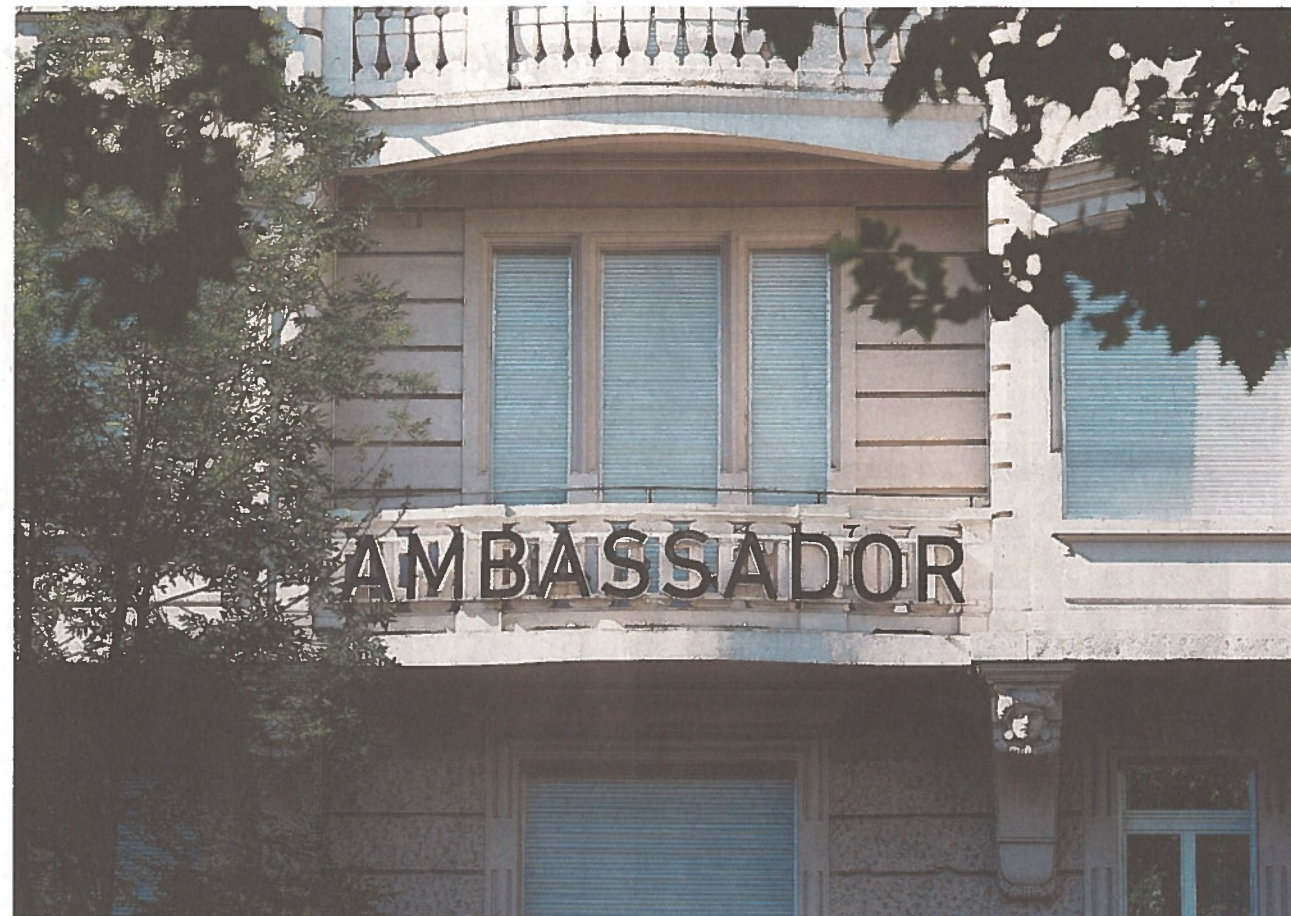
Die neuen Besitzer wollen das Hotel «Ambassador» für rund 10 Millionen Franken erweitern und sanieren.
