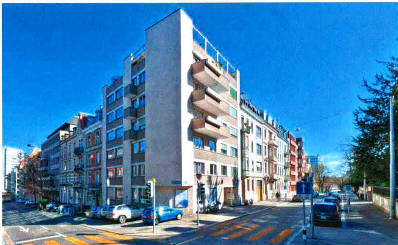
Freigutstrasse 26, Zürich: Im ehemaligen Büroobjekt überwiegt heute die Wohnnutzung
