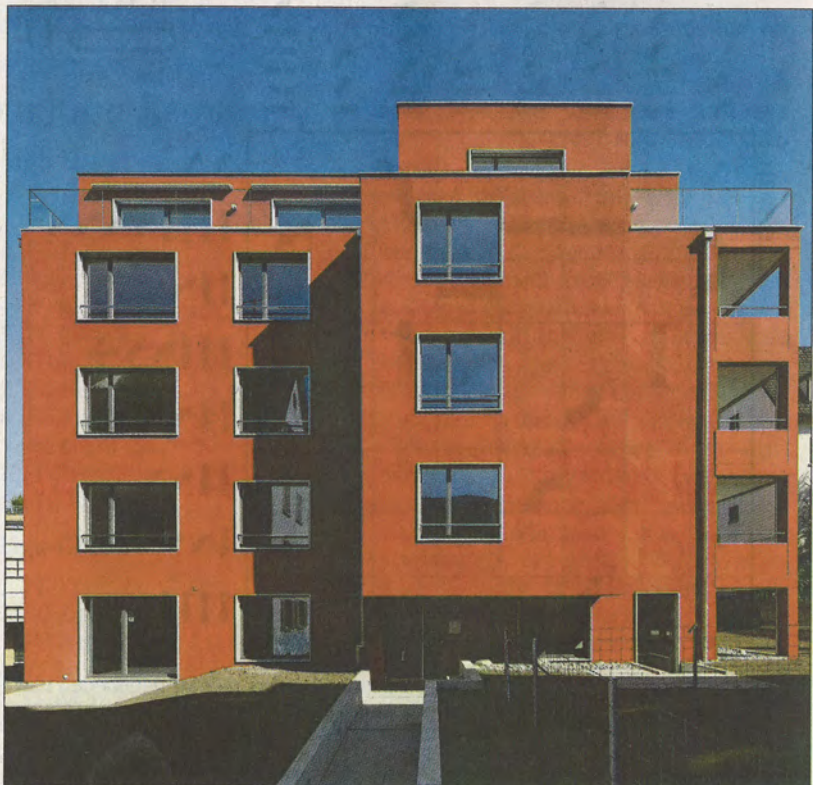
Die Zolliker Meili Unternehmungen AG schuf mit dem Neubau an der Albisstrasse 97 ein ganz spezielles Mehrfamilienhaus. (zvg)
